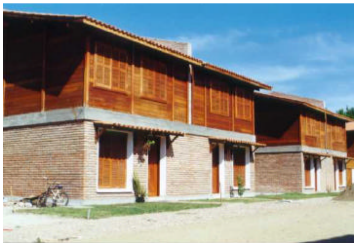
Foto 01 –Unidades habitacionais de 2 e 3 dormitórios
