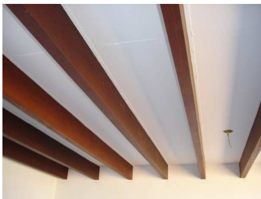
Figura 1. Vista interna de residência com estrutura mista de madeira e concreto
