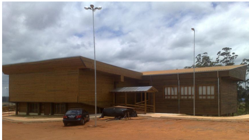
Figura 1 – Prédio que abriga a sala de professores, laboratórios, administração e anfiteatro da FATEC de Capão Bonito (SP).
