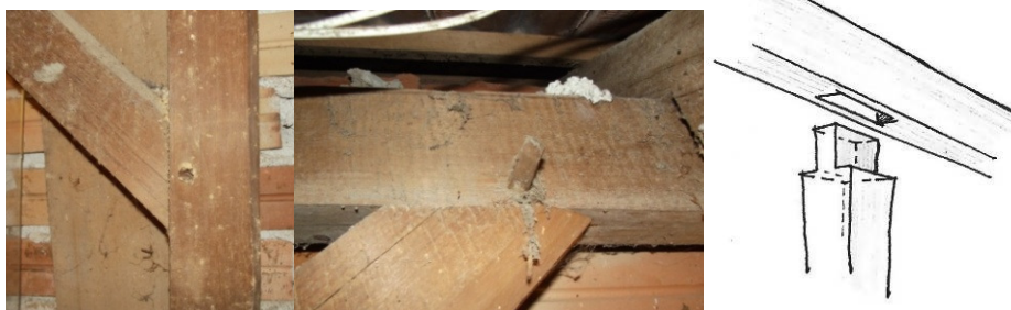
Figura 3. Pendural e mão-francesa com encaixe. Figura 4. Barrote e mão-francesa fixados por cavilha. 5. Detalhe do encaixe (caixa e espiga).
