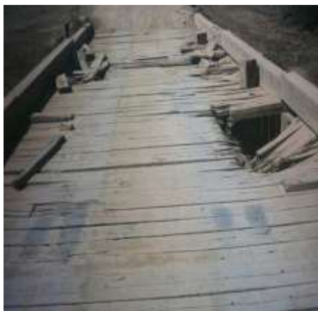
Figura 3. Ponte de madeira. Rodovia MT 208, MANTELI (2009).
