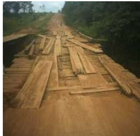
Figura 2. Ponte de madeira. Rodovia MT 208. MANTELI (2009)
