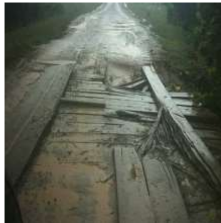
Figura 4. Ponte de madeira. Rodovia MT 208, MANTELI (2009).
