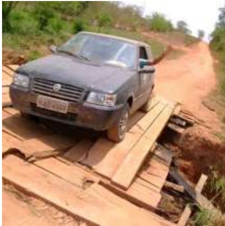
Figura 1. Ponte de madeira. Rodovia MT 208. MANTELI (2009)
