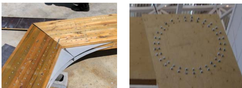
Figura 1. Nós com ligações resistentes a momentos com (esq a ) e sem (dir a ) chapa(s) de aço
