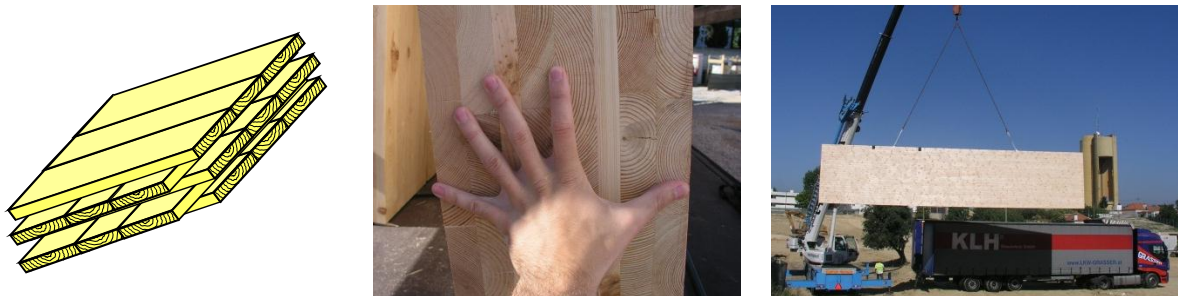
Figura 1 – Painel de madeira lamelada-colada cruzada.
