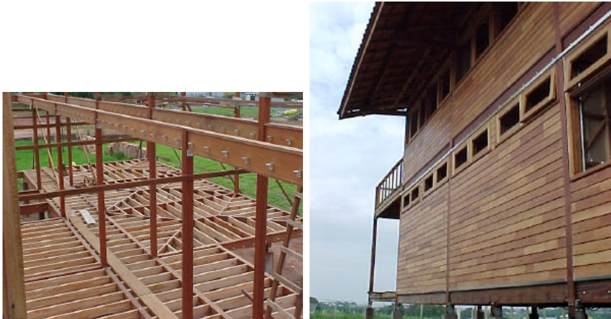
Figura 1 – Exemplo de utilização de viga composta pregada.
