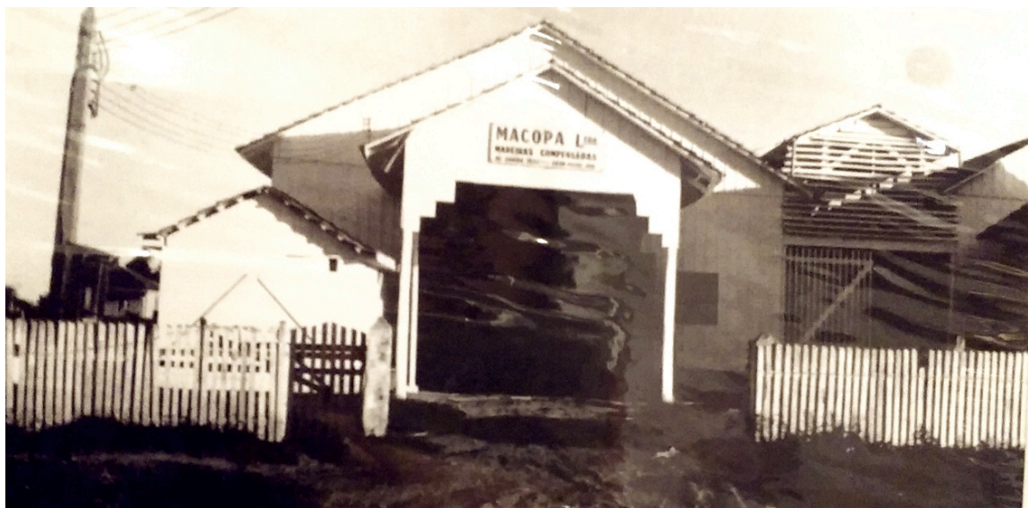
Figura 1: Primeiro galpão da Macopá construído de madeira, na década de 1950.
