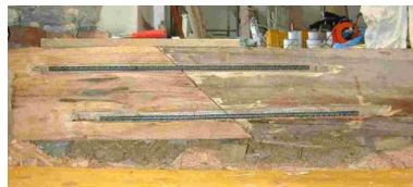
Figura 1. Substituição de elemento estrutural danificado. Fonte: SCHOBER et al. (2015).
