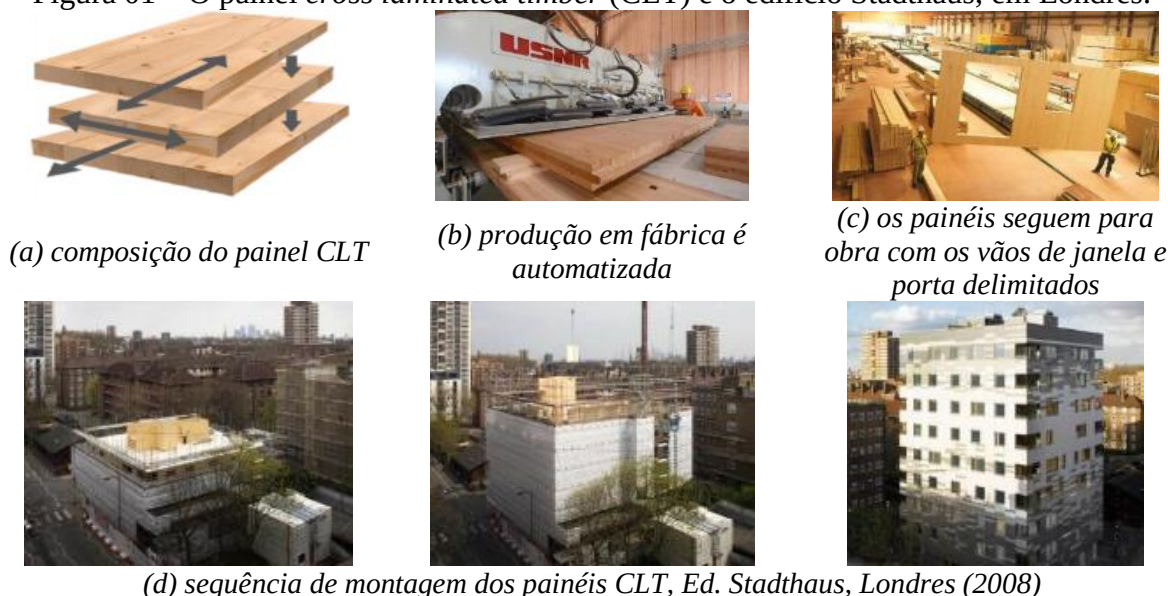
Figura 01 – O painel cross laminated timber (CLT) e o edifício Stadthaus, em Londres.
