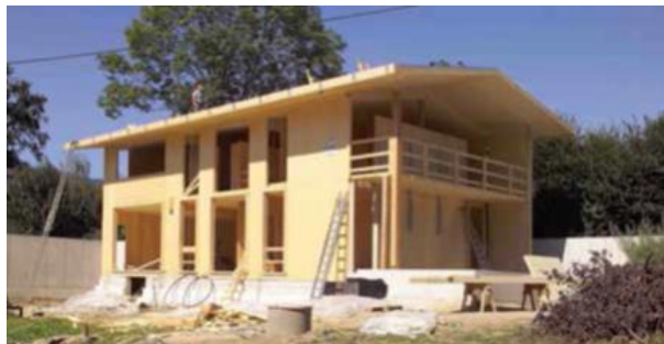
Figura 1- Residência unifamiliar construída em CLT na Áustria.
