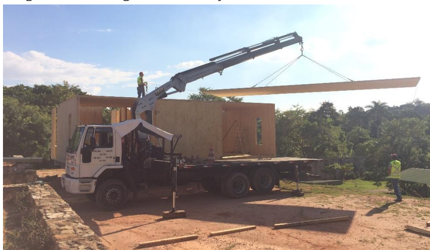
Figura 1 – Montagem de edificação residencial de CLT no Brasil
