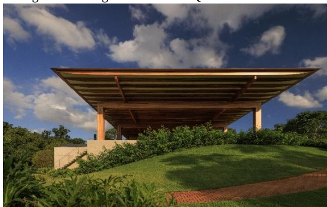
Figura 1 - Fotografia frontal da Quadra de Tênis - RDJ
