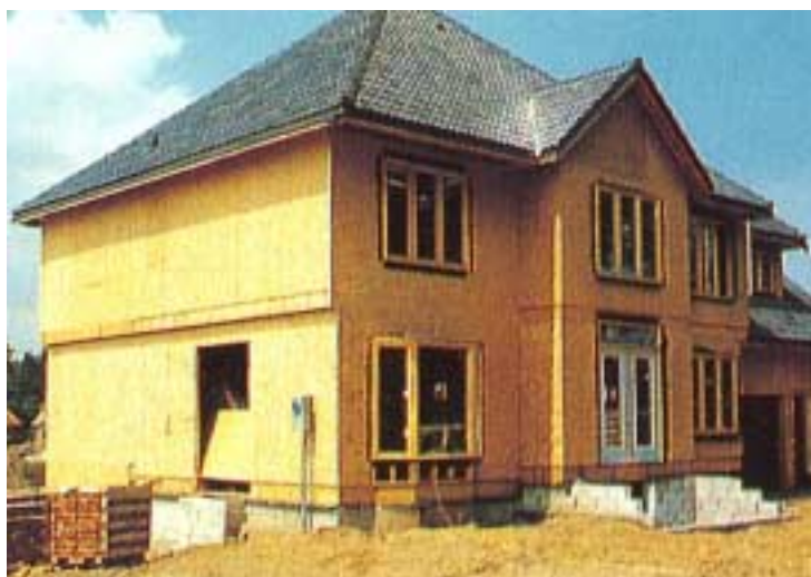
Figura 1 – Construção de casas em OSB
