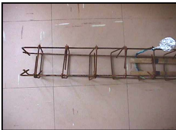
Figura 1 – Detalhe da armadura da viga 1
