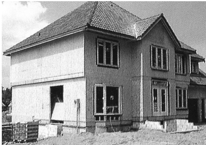
Figura 1 – Construção de casas em OSB
