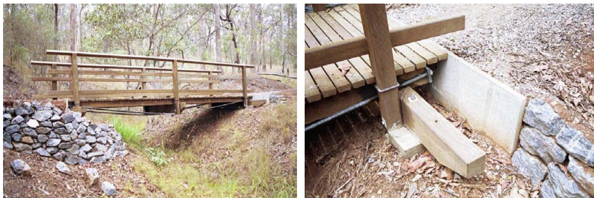
Figura 2– Passarela de madeira com vigas-vagão na Austrália.
