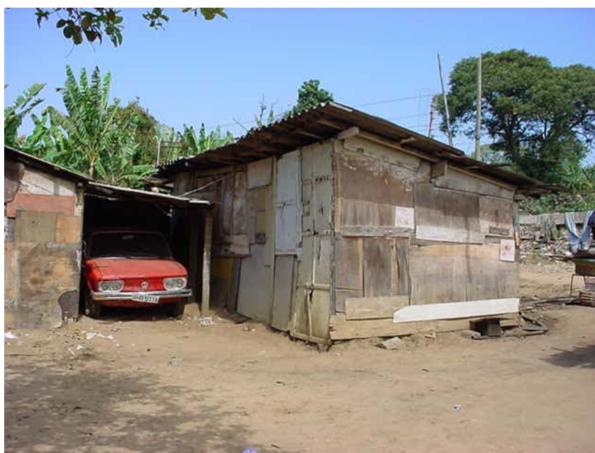
Figura 1 – A presença da garagem, e a vedação com madeira (Favela Vale das Antas).
