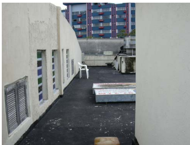
Figura 1 - Laje de cobertura do fundo da edificação com janela (à esquerda, com fechamento em veneziana) de acesso à estrutura de madeira.
