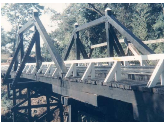
Figura 1 - Ponte de viga rígida com dois pendurais
