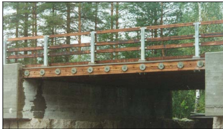
Figura 1–Puentes tensados de madera construido en Noruega
