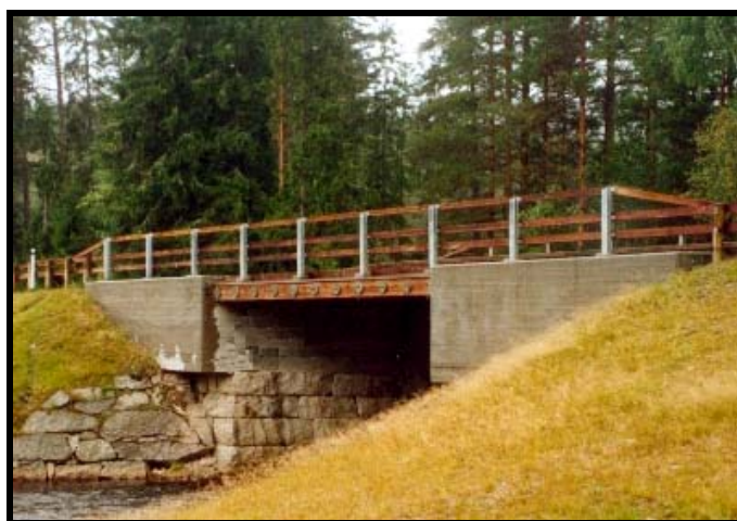
Figura 1–Puente de madera tensado transversalmente de Noruega.
