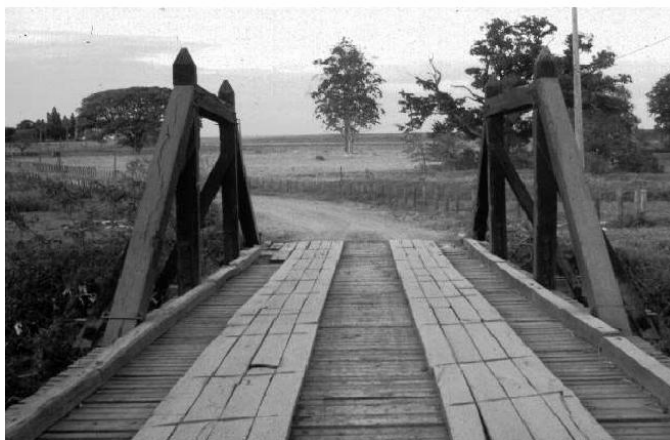
Figura 1- Tabuleiro típico de pranchas serradas. Fonte: LaMEM
