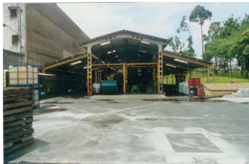
Figura 02 – Vista frontal da Estação antes de sua ampliação.
