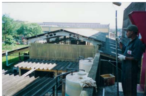
Figura 03 – Vista Posterior da Estação antes de sua ampliação.
