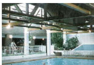
Encontro Banzos-Pilar em uma estrutura de cobertura
