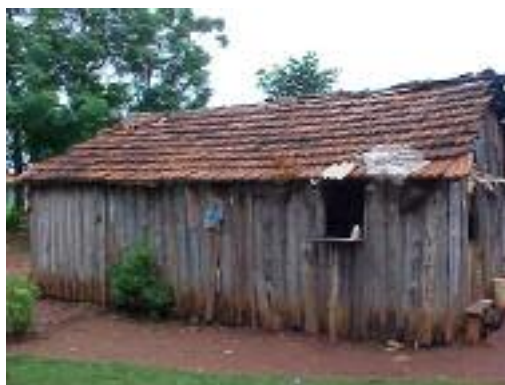
Figura 1 - Exemplo de habitação precária do assentamento Rural da Fazenda Pirituba, Itapeva, SP.
