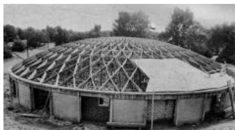
Figura 4 – Cúpula lamelar do centro de recreação Pine Hills nos Estados Unidos. Diâmetro: 42,6 m. Fonte: HUNTINGTON (1975).
