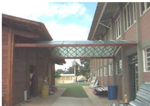
Figura 2 – Protótipo de abóbada lamelar cilíndrica construído no LaMEM para o desenvolvimento da etapa experimental deste trabalho. Dimensões em planta: 5,18 m x 4,00 m.
