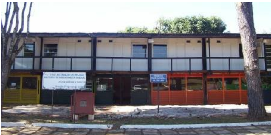
Figura 1 - Vista frontal do Prédio OCA II da Universidade de Brasília.
